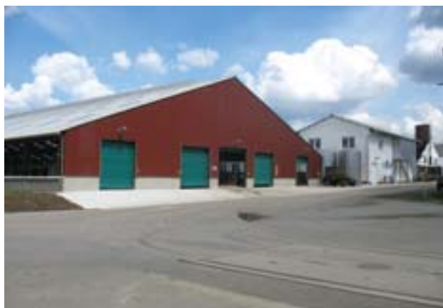
■ Stáj K510 pro dojnice nově vybudovaná na ŠZP Nový Jičín (2006)
