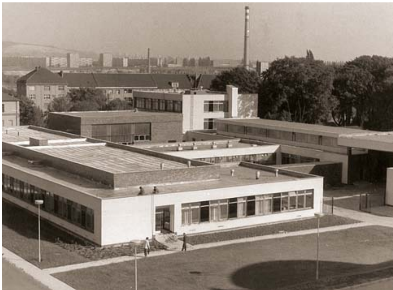
■ Nově postavená budova chirurgicko-ortopedického pavilonu (1980)
