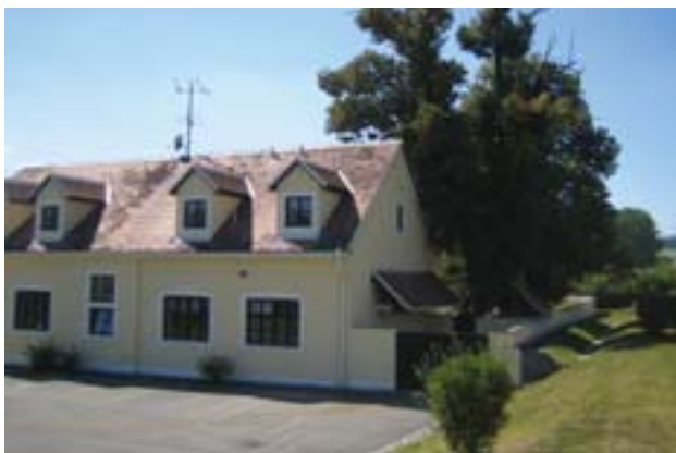
■ Rekonstruované Ubytovací a stravovací zařízení Nový Dvůr (2008)
