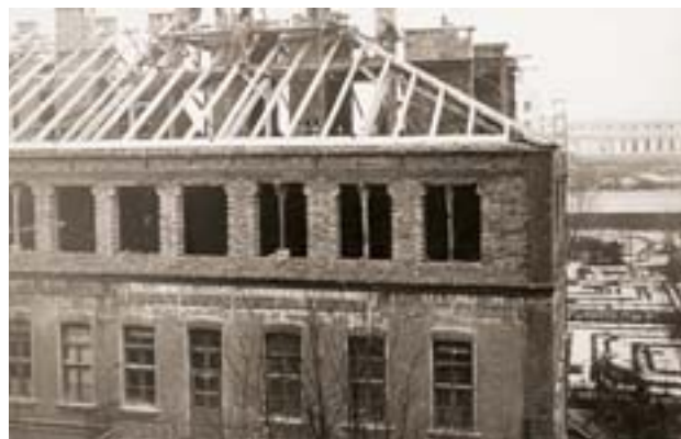
Dostavba budovy chemického ústavu (dnešní budova č. 31) (1931)
