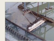
Stírací rameno plovoucího kalu
