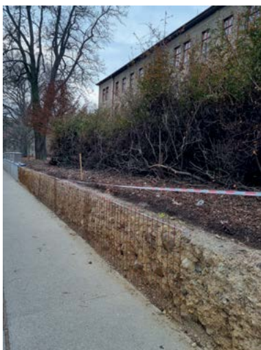
Oprava se týká celé levé hranice univerzity v ulici Palackého
