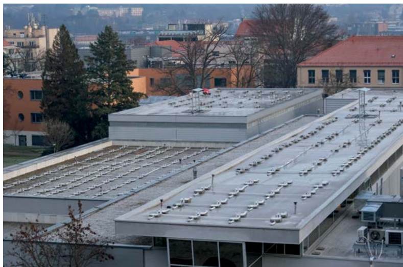
Práce na umístování fotovoltaických panelů na Pavilonu klinik malých zvířat
