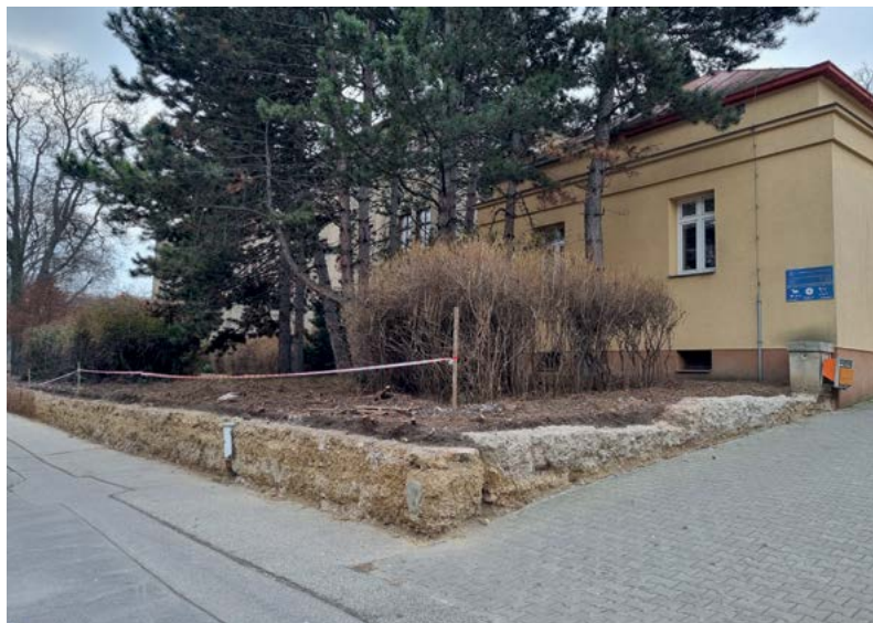
Oprava zídky u vstupu do univerzity
