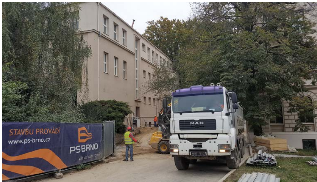
Rekonstrukce budovy č. 31 probíhá i za účasti těžké techniky
