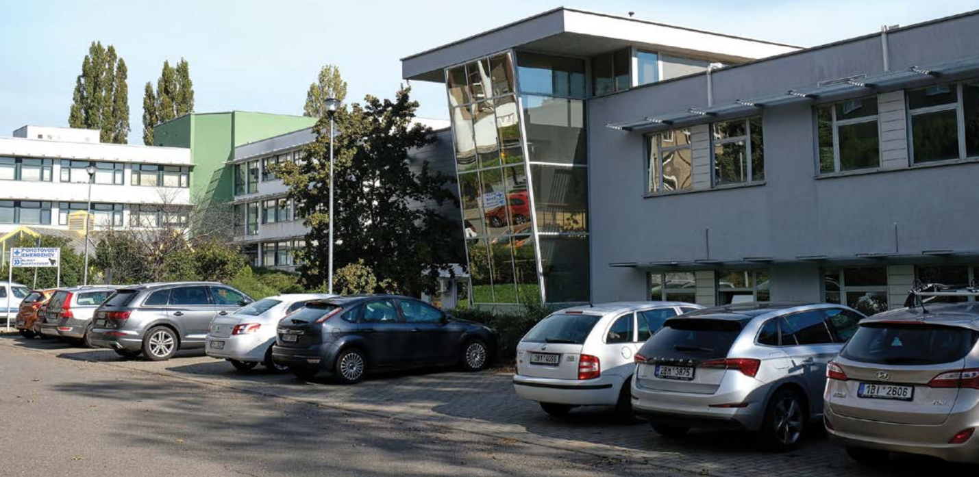
Pavilon Klinik malých zvířat postavený v roce 2003
