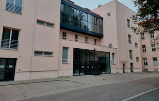
Opravená komunikace a parkoviště mezi budovou č. 31 a 32
