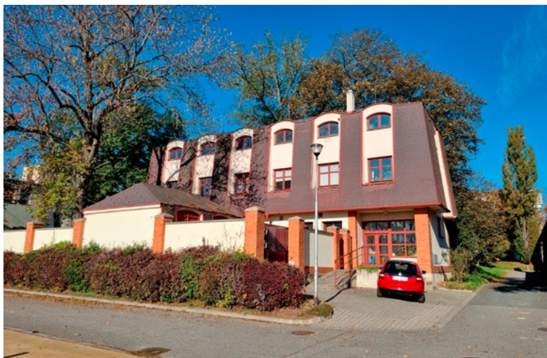
Infekční pavilon pro velká zvířata po rekonstrukci
