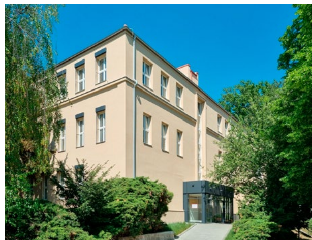
Byla uvedena do provozu rekonstruovaná budova č. 31
