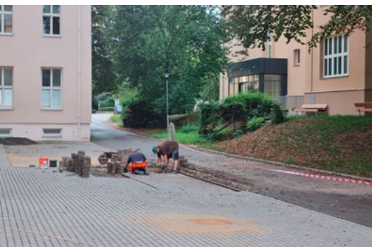
Oprava komunikace před Ústavem biologie a chorob volně žijících zvířat
