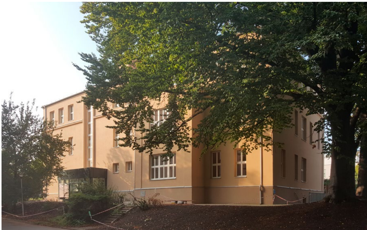
Rekonstrukce budovy č. 31
