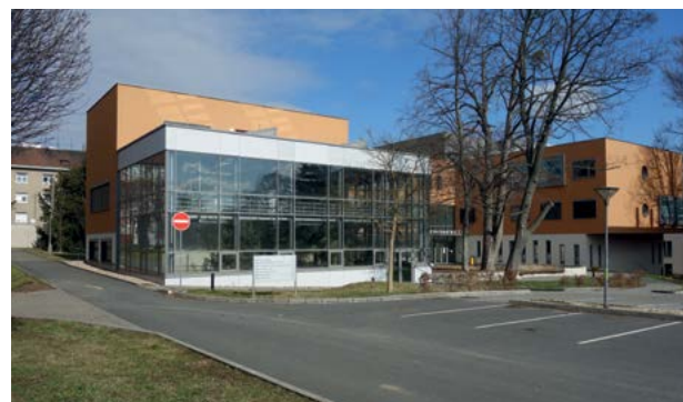
Zahájení výstavby Pavilonu Farmacie II 2013 s ukončením v roce 2014
