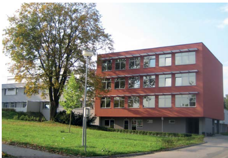
Vznik Pavilonu klinik malých zvířat v roce 2003
