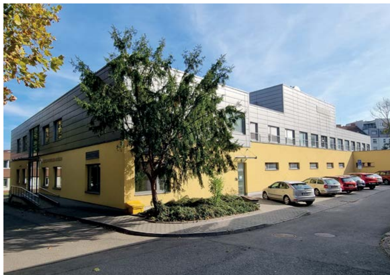
Výstavba nového komplexu Pavilonu kliniky chorob prasat (2010)
