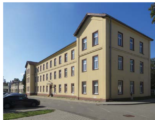
K vnitřní rekonstrukci je připravena budova č. 15
