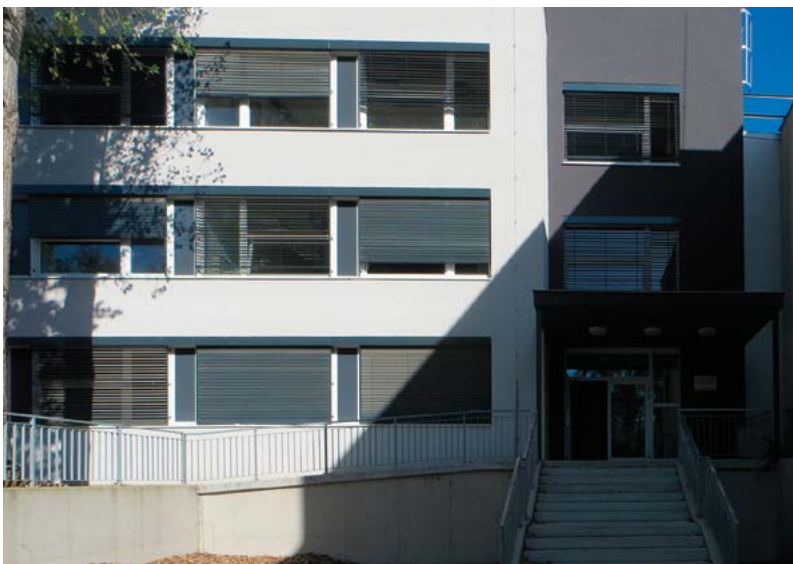
Vstup do modernizované budovy č. 25
