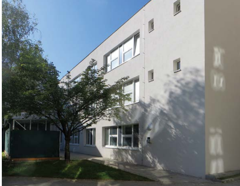
Rekonstruovaná budova č. 25
