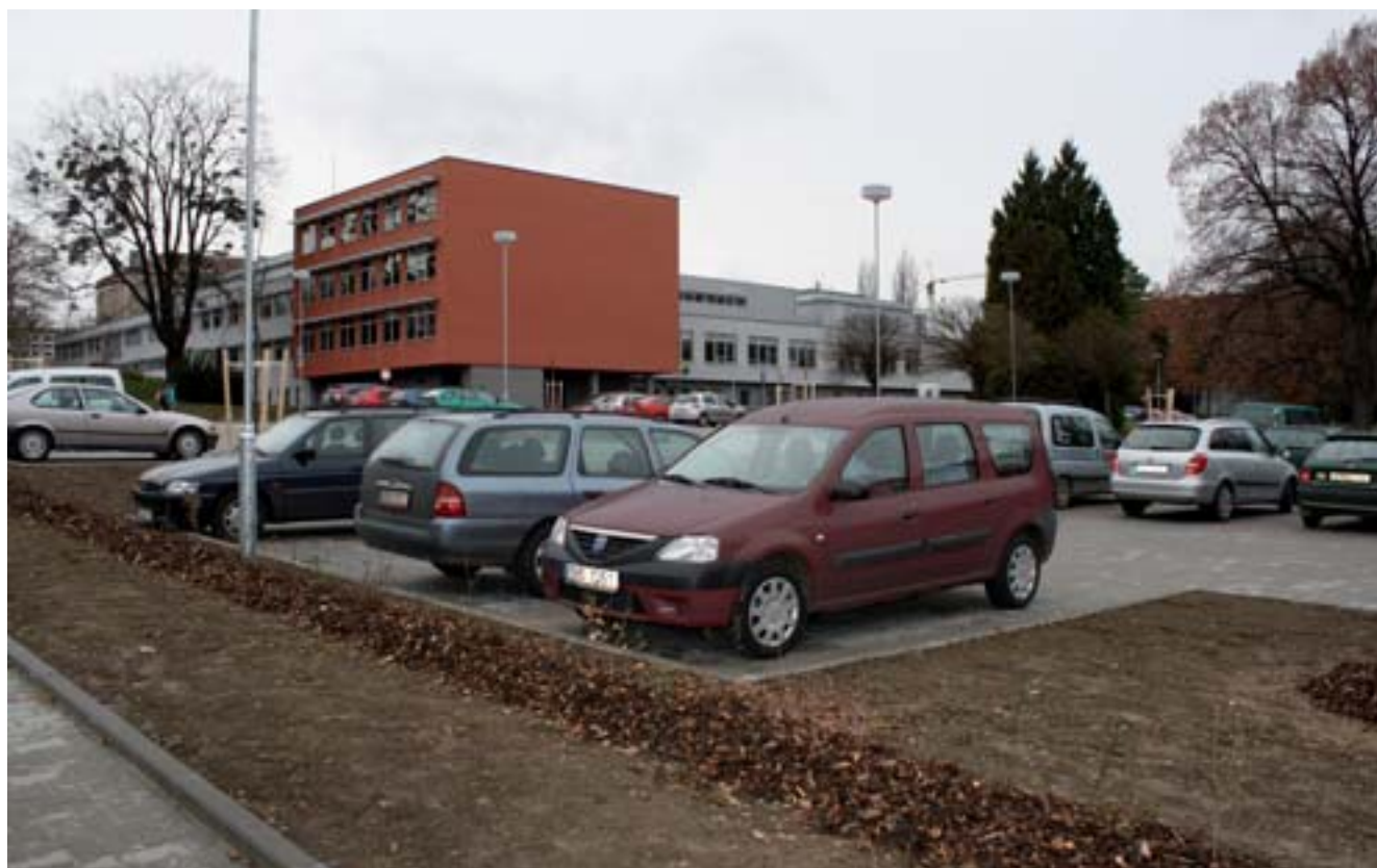
■ Pohled na nově zbudované centrální parkoviště univerzity
