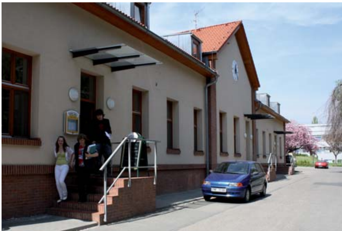
■ Pohled na ubytovací a stravovací centrum
