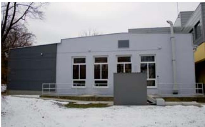
■ Pohled na rekonstruovanou stavbu
