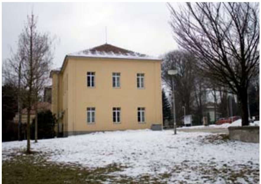
■ Budova po rekonstrukci
