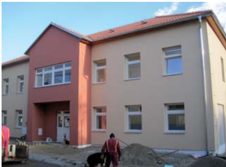
■ Zrekonstruovaná budova č. 2
