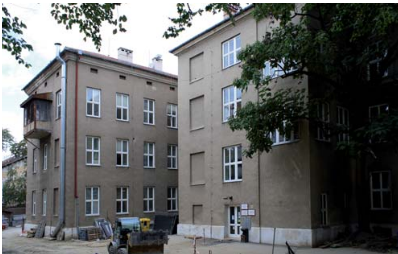
■ Budova č. 32 v současném stavu
