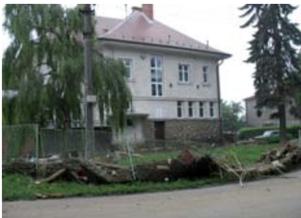
■ Poškozené budovy ŠZP a okolí
